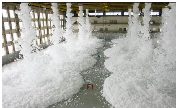
Рисунок 4 - Спринклерная установка пожаротушения
